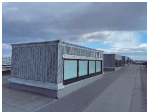
漏水対策工事を実施した 屋上ハイサイド
